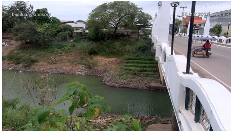
C031703 : สะพานห้วยหลวงอนุสรณ์ ต.จุมพล อ.โพธิ์ชัย จ.หนองคาย
